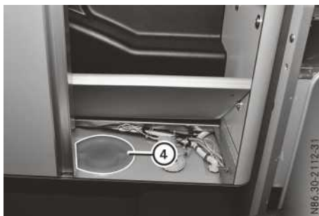
Orifice de nettoyage du réservoir d'eau propre
